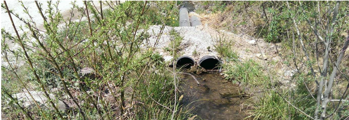
Abb. 4 Verlegte Rohre als Sofortmassnahme gegen die Versickerung
