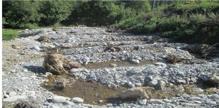
Abb. 7 Neugestaltung des Aubächlis mit Mäandrierung und Strukturelementen als Unterschlupf (Wurzelstöcke)
