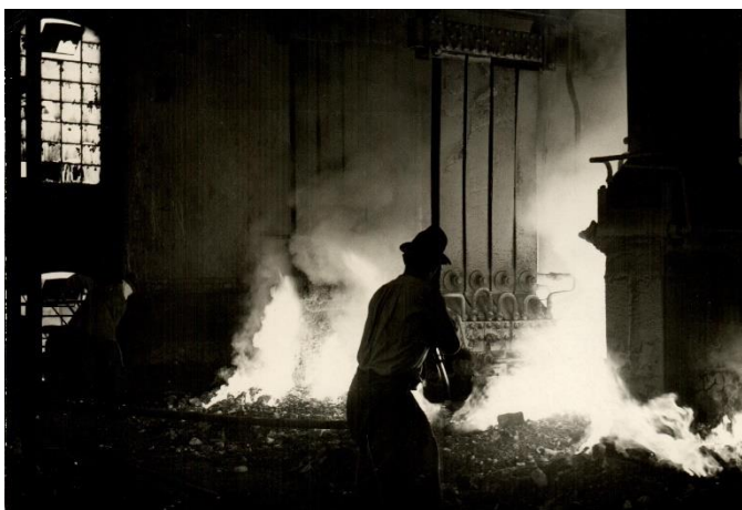
Beim Abstrich am Elektroofen
