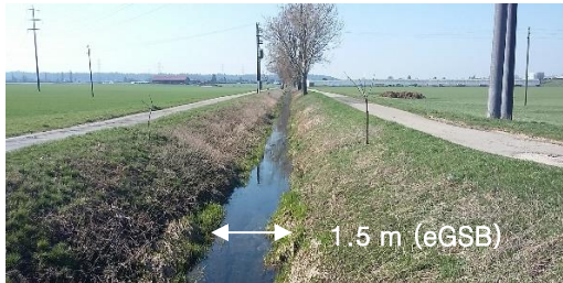
Abb. 2 Beispiel einer Berechnung der natürlichen Gerinnesohlenbreite
