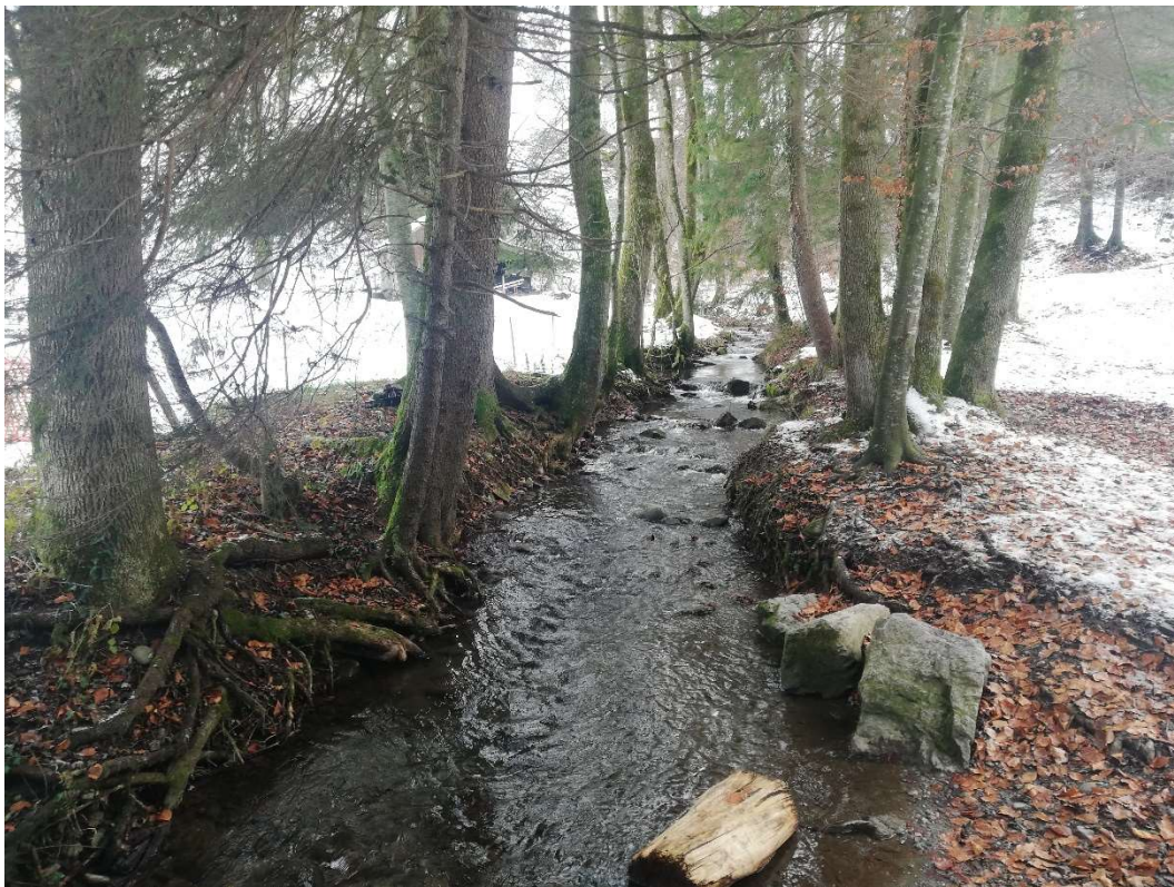
Abbildung 10: Dorfbach, Abschnitt Herrematte, Blick gegen Fliessrichtung. Baumwurzeln entlang Ufer, Foto vom 19.12.2022
