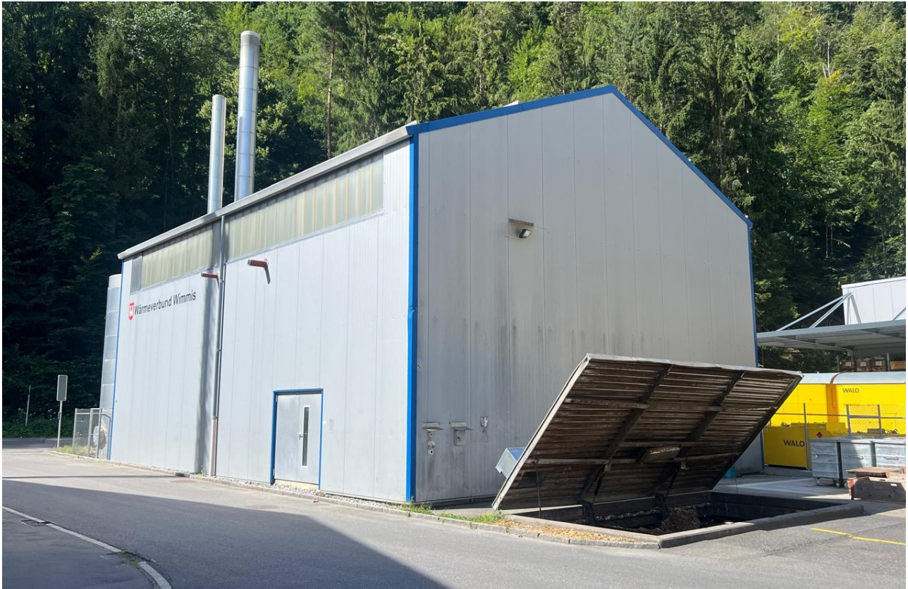
Wärmezentrale mit Holzschnittzilsilo
