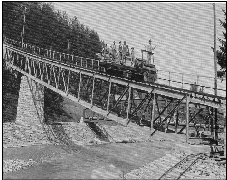
Ein Materialwagen steht auf der Brücke vor der Talstation Mülmen im Einsatz. Auf die Chassis dieser Wagen konnten später die definitiven Wagenkasten aufgebaut werden.
