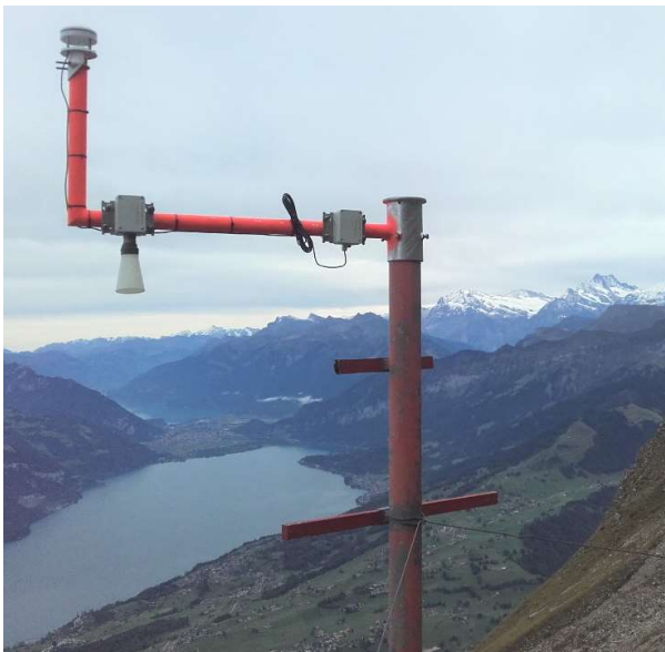
Fertig montierte Sensoren
