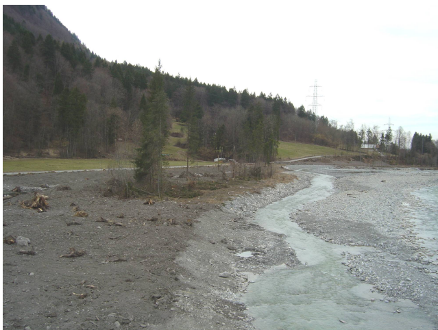
Unsichtbare, aber stabile Ufersicherung
