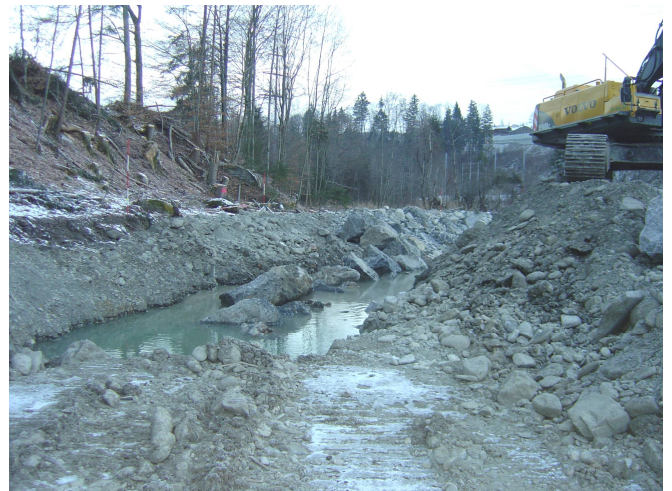
Einsatz schwerer Maschinen
